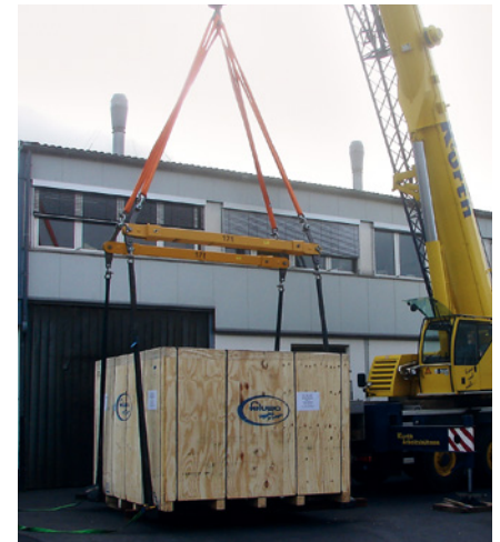
Spreiztraversen-Gehänge Anschlag unterhalb des Lastschwerpunktes
