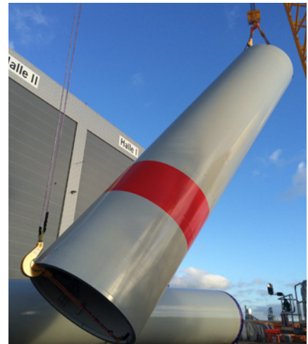
120t Hebevorgang einer Turmsection mit Axzion J-Hook und Axzion Pully inkl. Turmstabilisierung
